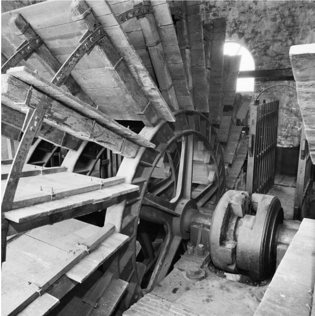
Schepraderen gemaal Mastenbroek ter plaatse van de schuifkoppeling
