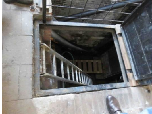
Kelder in de machinehal met geopend luik
